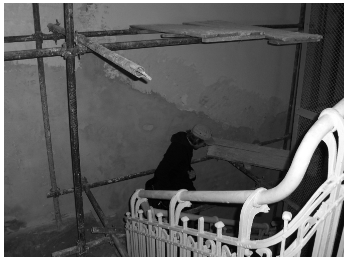
Lauri uskaltautui testaamaan Lenin-hostellin rappukäytävän
